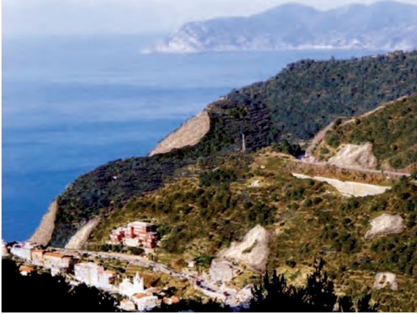
FIG. 3 — 2000, effets de la construction de routes et d'hôtels et simulation de l'évolution de la pente si les terrassements n'avaient pas été restaurés.
