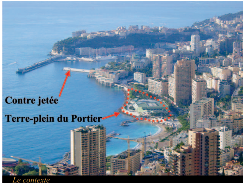
FIG. 1. — Réalisation des infrastructures de l'extension territoriale entre la contre-jetée et le terre-plein du Portier
